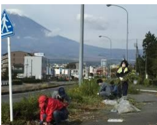
R138御殿場IC出口周辺草刈・清掃作業
