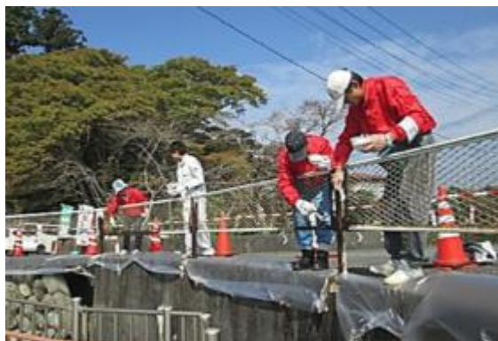
観光案内施設前の防護柵塗り替え作業
