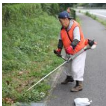
道路の草刈作業
